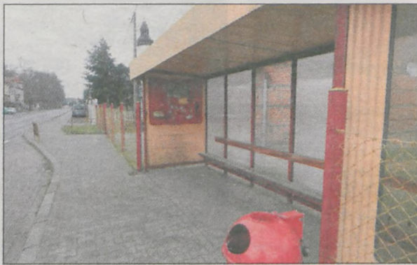
Wyremontowany przystanek w Górze
