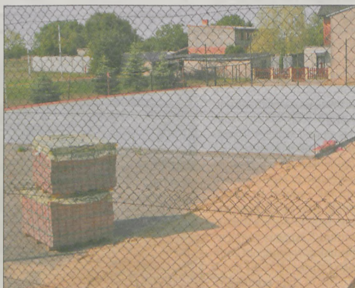
Jeszcze kilka tygodni potrwa budowa skateparku i zewnętrznej siłowni
