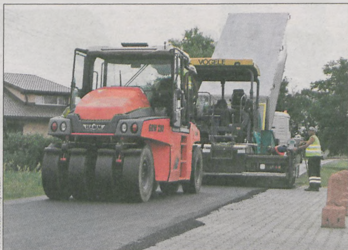
Drogowcy w ubiegłym tygodniu skończyli wylewanie nawierzchni bitumicznej na ul. Okrężnej w Noskowie
