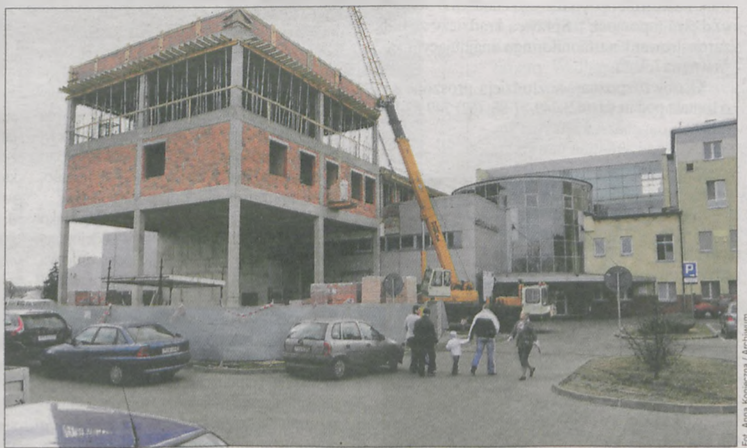
Dwuetażowa rozbudowa szpitala rozpoczęła się latem 2011 roku. Miała trwać do grudnia. Pierwsza część pobudowana została jednak dopiero w czerwcu 2012. Od tego czasu nowy obiekt stoi pusty i czeka na oddanie do użytku. O dalszej rozbudowie nikt na razie nie mówi
