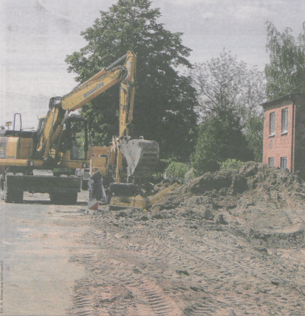
Budowa kanalizacji jest coraz bliżej Bieździadowa. Sieć została już pociągnięta z Lasek (na zdjęciu) z kierunku Chrzana
