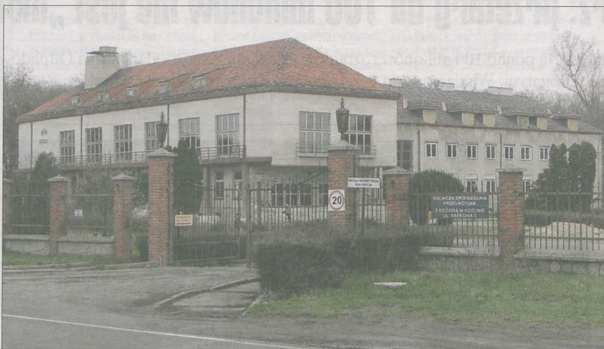
6 milionów złotych powiat chce w przyszłym roku przeznaczyć na częściową adaptację budynku w Kotlinie. Kiedy starosta Mikołaj Szymczak kupował nieruchomość w 2012 roku, jego zastępca Mirosław Drzazga mówił, że w 2013 Boże Narodzenie mieszkanki DPS-u w Zakrzewie spędzą już w nowej siedzibie
