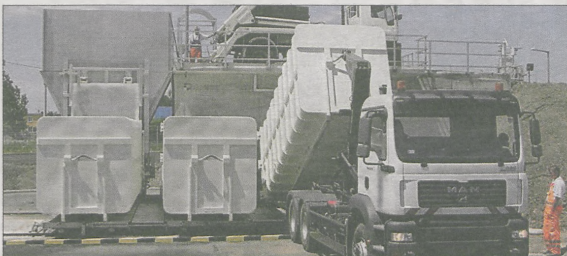
Latem został rozstrzygnięty przetarg na budowę stacji przeładunkowej w Mateuszewie (gmina Śrem), która jest elementem instalacji mechaniczno-biologicznego przetwarzania odpadów komunalnych w ramach istniejącego Zakładu Zagospodarowania Odpadów w Witaszyczach.
