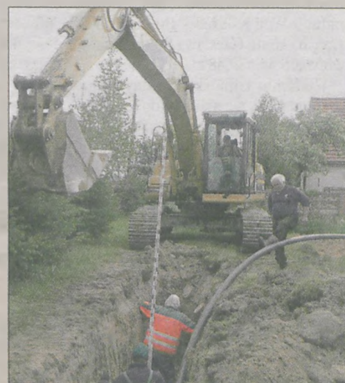
Dwa lata temu wybudowano kanalizację w Wilczy
