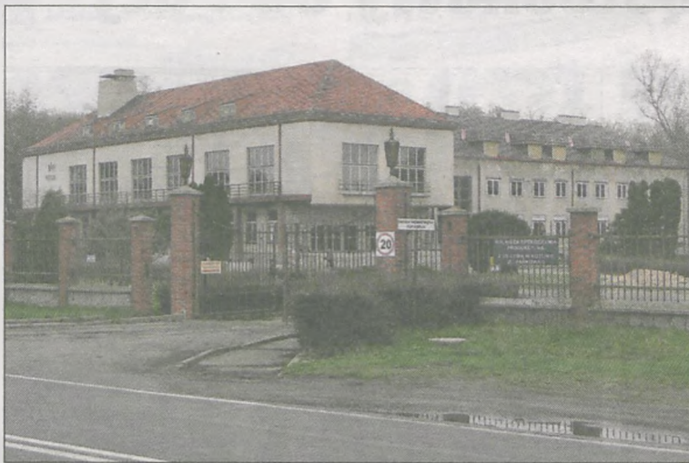
Adaptacja biurowca po RSP będzie kosztowała powiat ok. 10 mln zł
