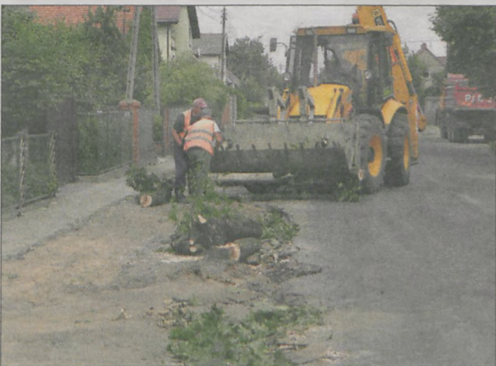
Poszerzenie jezdni wymagało usunięcia drzew z poboczy
