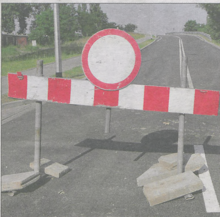
Zakończyła się przebudowa wiaduktów. Teraz obiekt czeka procedura odbiorowa i wydanie pozwolenia na użytkowanie
