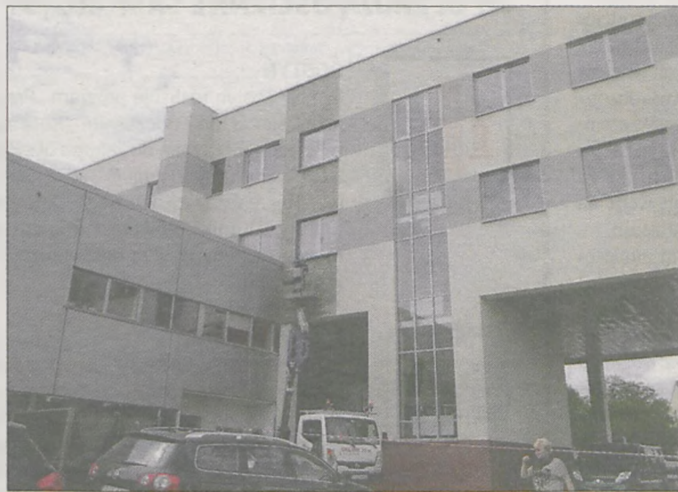
Wykonanie zaleceń straży pożarnej wymagało usunięcia części nowej elewacji i wymiany styropianu na wełnę mineralną
