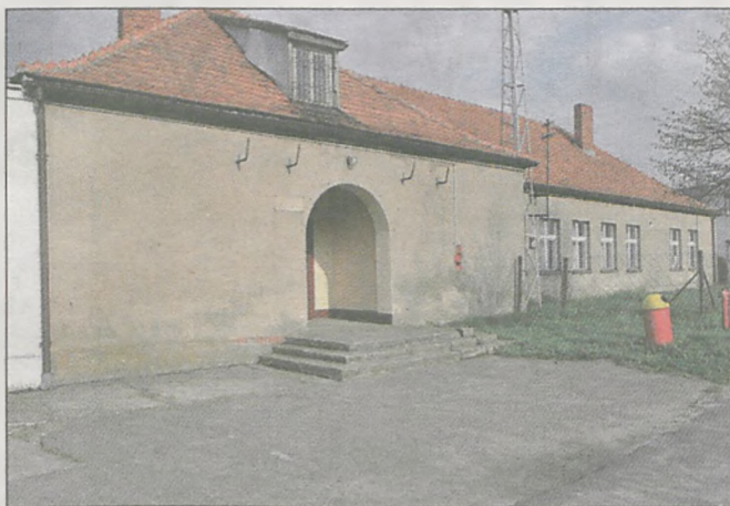
Sala wiejska w Dobieszczyźnie przygotowywana jest do remontu
