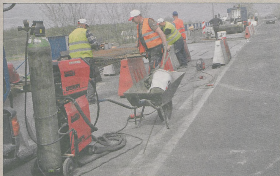
Płytę żelbetową przygotowują w czwartek
