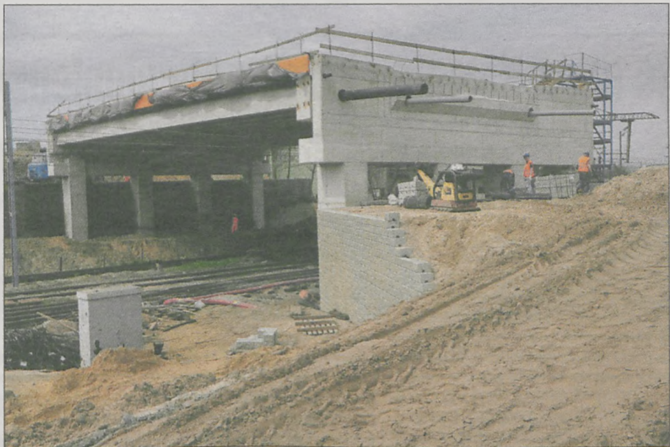
Do końca czerwca mają trwać roboty przy budowie wiaduktów w Jarocinie
