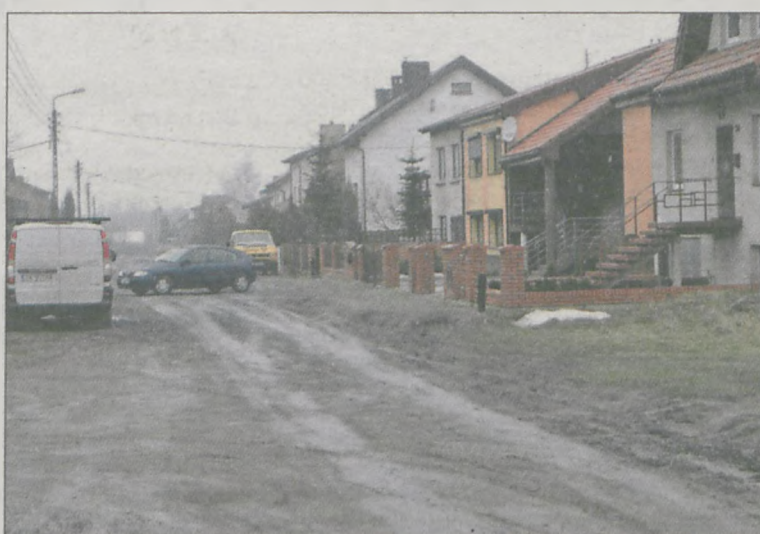
Do końca kwietnia powinien się poprawić stan nawierzchni ul. Zagrodowej w Jarocinie
