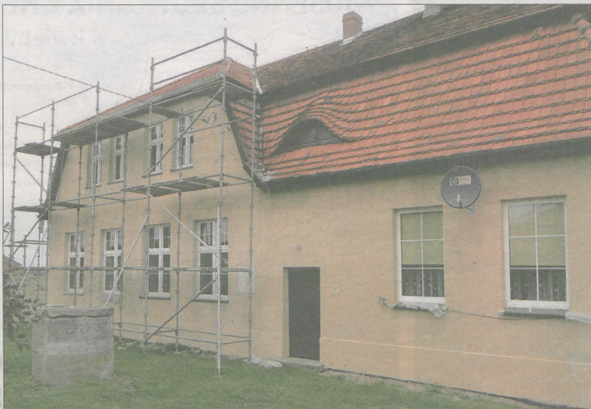
W ubiegłym roku gmina wyremontowała salę wiejską w Brzóstkowie
