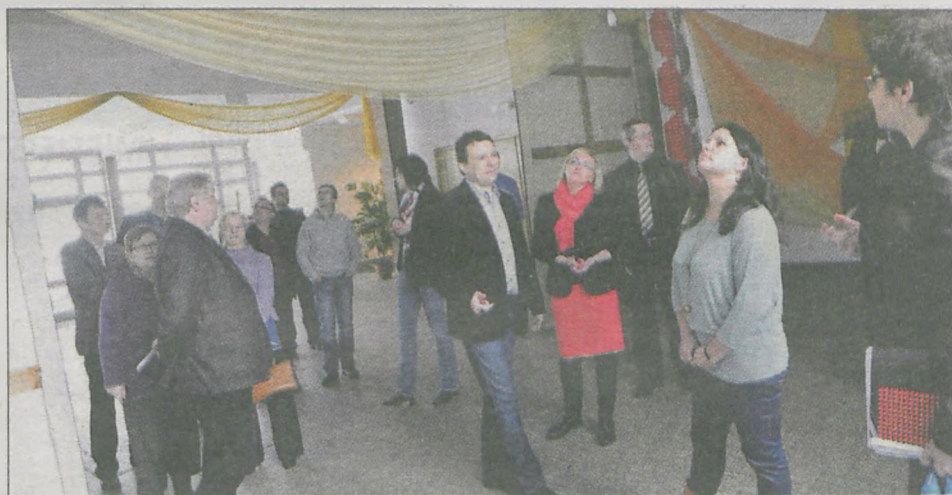
Radni zwiedzili wszystkie pomieszczenia - widzieli zacieki, odpadający tynk i zatęchłe pomieszczenia
