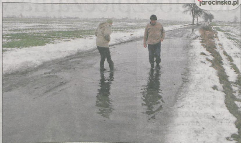
Tak wyglądała droga, w minioną środę po odwilży i opadach deszczu
