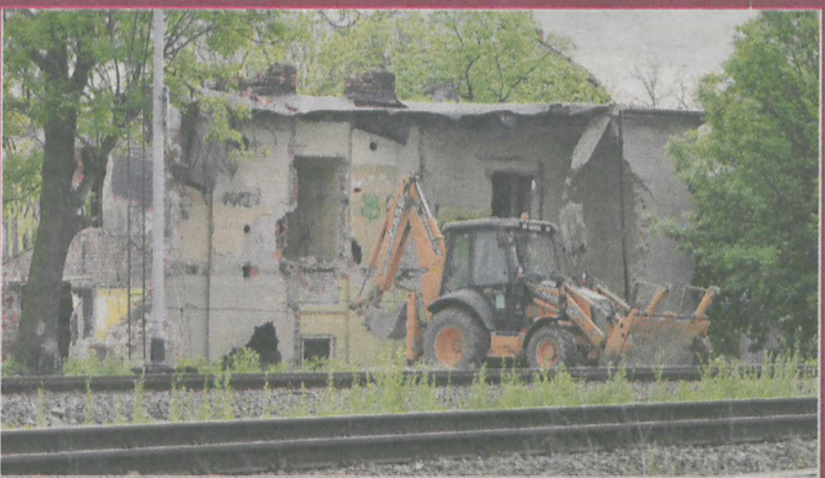
W maju przystąpiono do rozbiórki budynku. Po dawnym Domie Kultury Kolejarza nie pozostał żaden ślad
