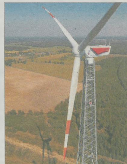
Najwyższa elektrownia wiatrowa powstała w okolicy miejscowości Laasow (Niemcy). Jej kratowa wieża ma wysokość 160 m, a elektrownia łopatą swojego wirnika sięga 205 m
