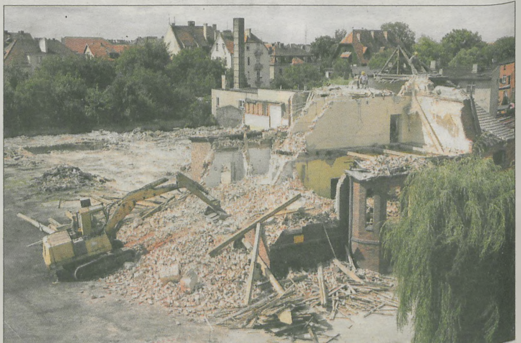
Obiekty „dwójki” zburzono w sierpniu ubiegłego roku
