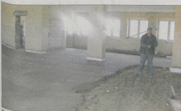
Posadzkę w świetlicy wylewano na początku marca
