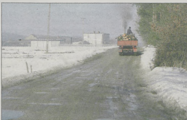
Gmina Jaraczewo zamierza wybudować drogę Gola - Skokówko (era)
