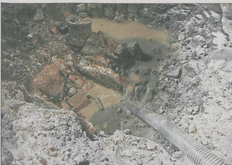
Odcięcie wody nie pomaga, żeby móc kopać, trzeba pompować
