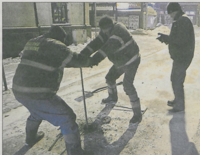
Przed północą wyciek udaje się opanować. Teraz wystarczy przebić się do skutych lodem zasuw i można puszczać wodę do sieci
