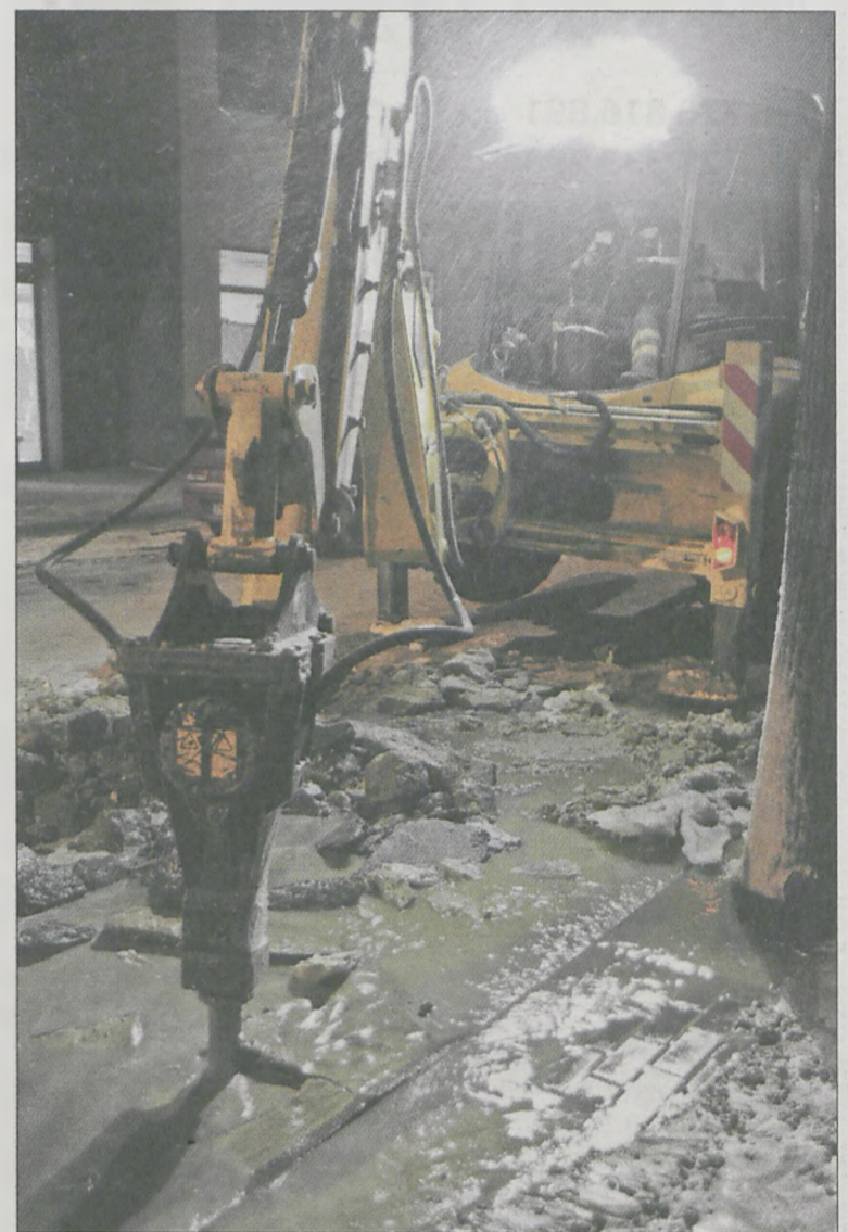
Przebite przez asfalt zajmuje chwilę, ale zamrożony na skalę grunt pod spodem to wielki problem, nawet dla ogromnego młota pneumatycznego
