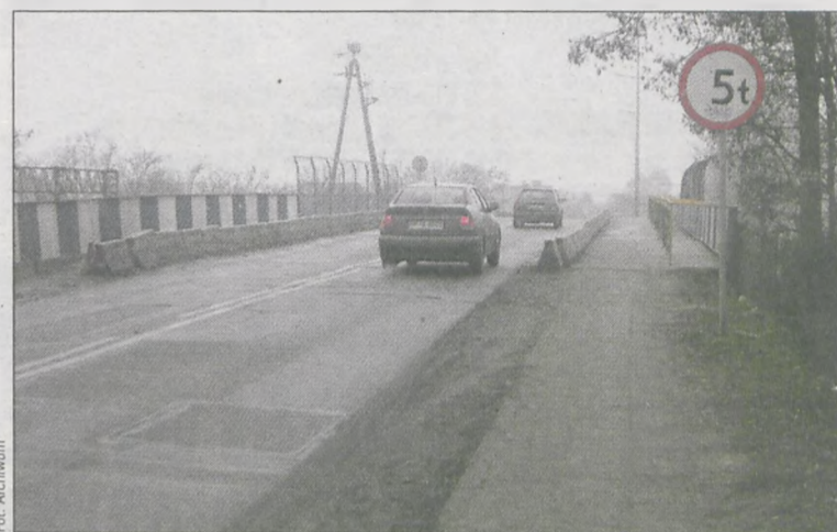
Wiadukty kolejowe przy ul. Powstańców Wlkp. czekają na przebudowę jeszcze co najmniej do 2012 roku
