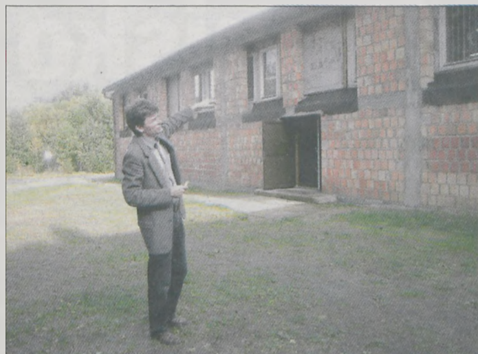
- Przebudowa sali gimnastycznej zakończy się w przyszłym roku zburzeniem starych ścian i termomodernizacją całego budynku - wyjaśnia dyrektor Sławomir Adamiak
