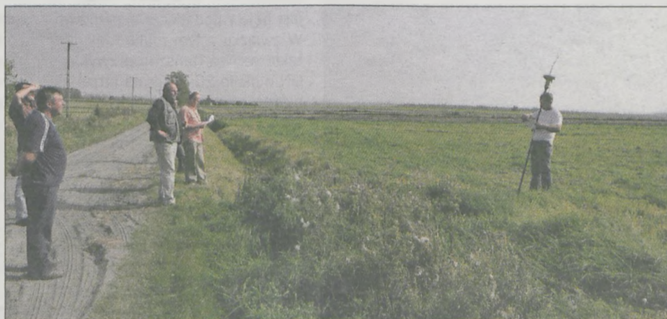
W ubiegły wtorek geodeci sprawdzali granice działek w okolicach Cielczy, po których ma przebiegać obwodnica
