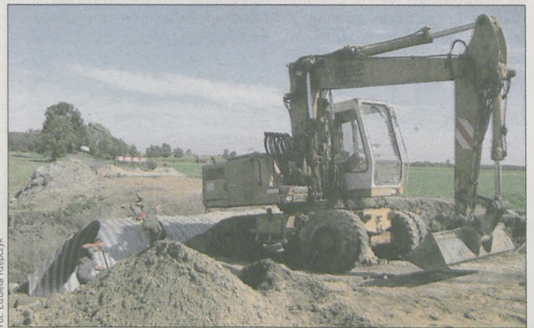
W minionym tygodniu trwały prace przy przebudowie mostu
