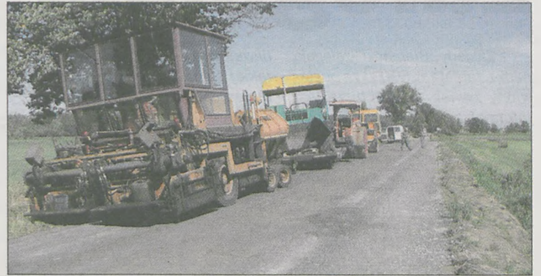
Cztery maszyny stały na poboczu przebudowywanej drogi w ubiegłą środę
