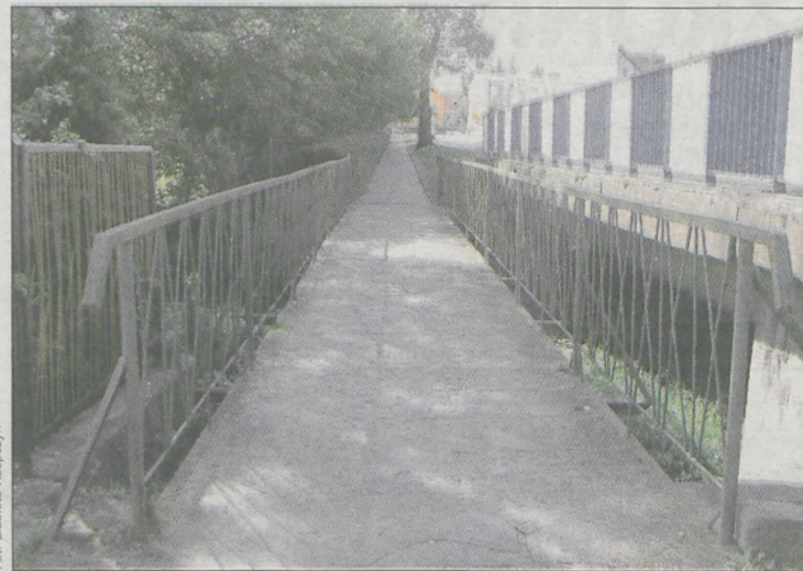
Do końca listopada ma być wyremontowana kładka na Obrze przy ul. Jarocińskiej w Jaraczewie
