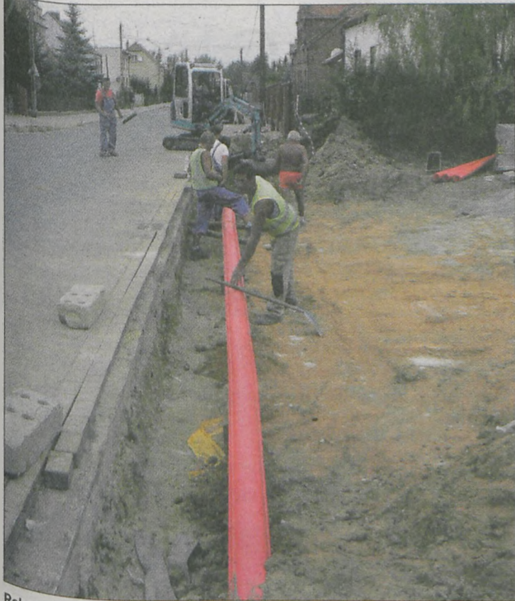
Robotnicy rozebrali kilkudziesięciometrowy odcinek ścieżki rowerowej
