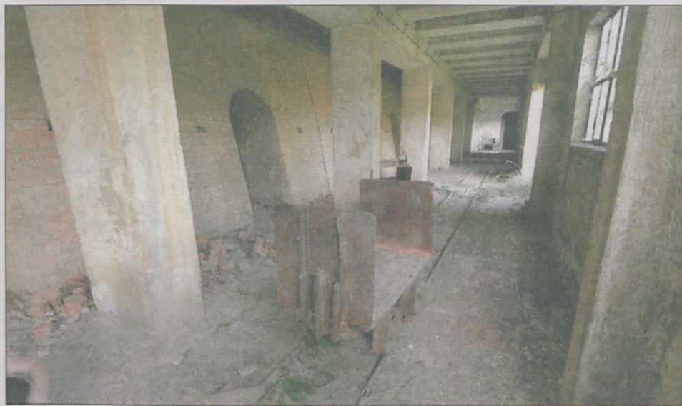
Technika pracy niewiele zmieniła się na przestrzeni wieku. Robotnicy ręcznie pchali wagoniki z gotowym wyrobem
