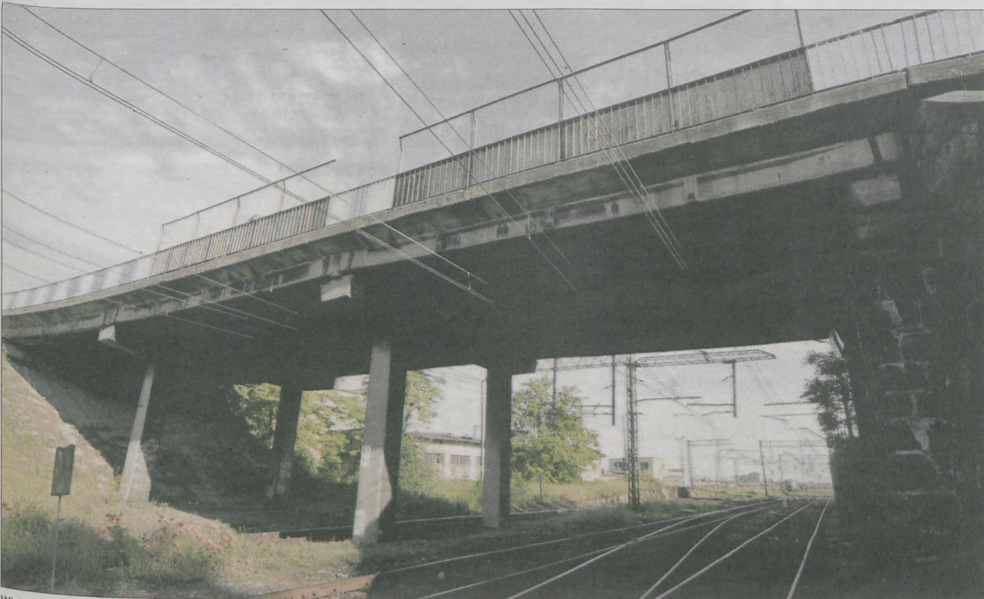
Wiadukt od strony zachodniej (z kierunku Leszna) jest jeszcze w dobrym stanie technicznym
