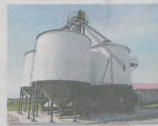
Linie technologiczne magazynów zbożowych
