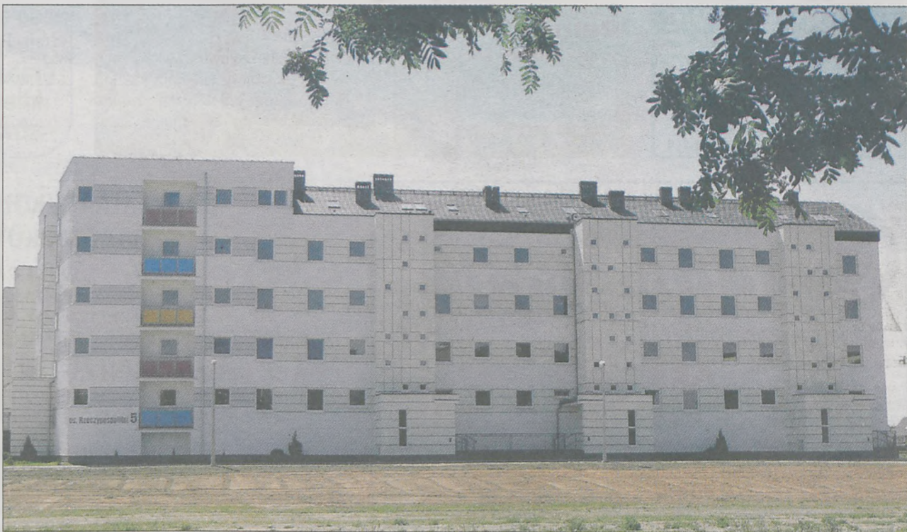
Budowa 63-rodzinnego bloku jest skończona. Część przyszłych najemców już urządziła swoje mieszkania, ale wprowadzić się nie mogą
