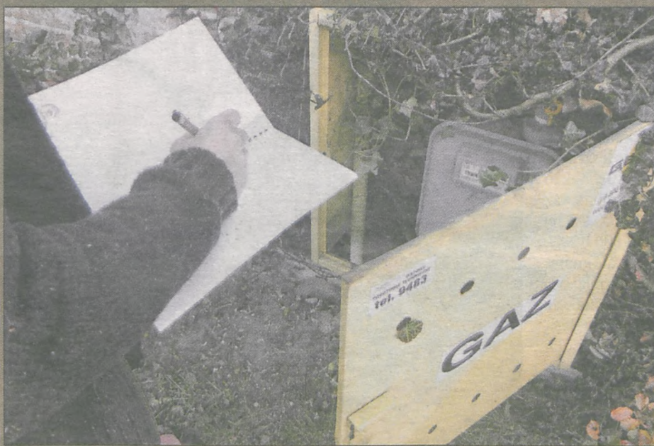
Pracownicy gazowni sami przeprowadzili kontrolę stanu technicznego licznika - jak się później okazało, zrobili to bezprawnie
