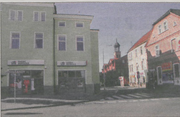
Świeżo wyremontowany budynek na skrzyżowaniu ulic Wrocławskiej i Paderewskiego czeka na najemców. Pierwszy zgłosił się jeden z banków. W tle klinkierowy biurowiec, w którym najprężniej działa apteka
