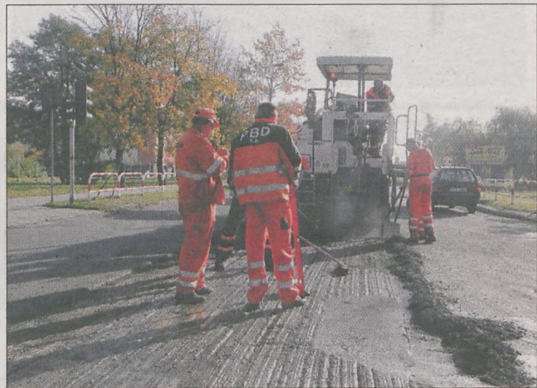
Do końca listopada mają trwać roboty na drodze krajowej nr 15. Dla kierowców oznacza to utrudnienia, zwłaszcza na skrzyżowaniu ulic Wrocławskiej i Powstańców Wlkp.
