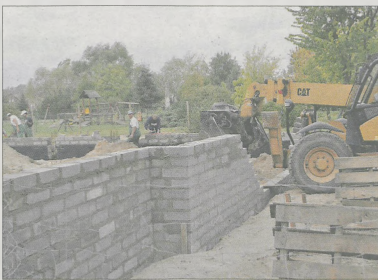
Trwa rozbudowa Domu Strażaka w Kotlinie
