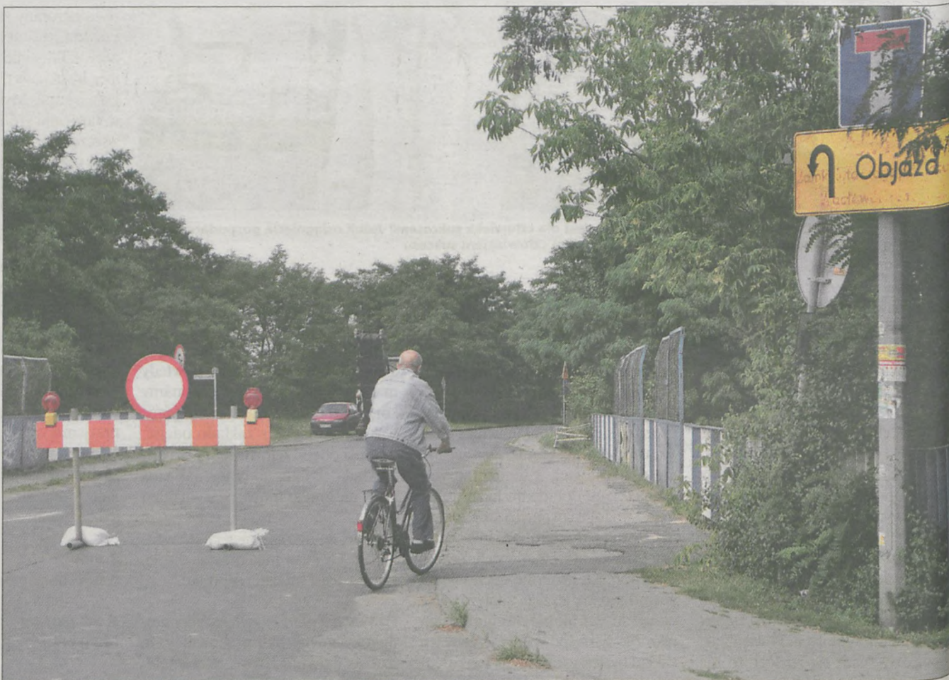
Mieszkańcy Ługów, mimo zakazu, korzystają z przejazdu przez wiadukty
