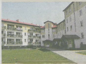
420 mieszkań w nowym bloku JTBS (mieszkanie 50 metrowe, cena za metr kw. 2.850 zł)
