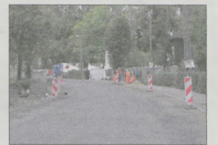
Remont drogi prowadzi powiat we współpracy z gminą Jarocin
