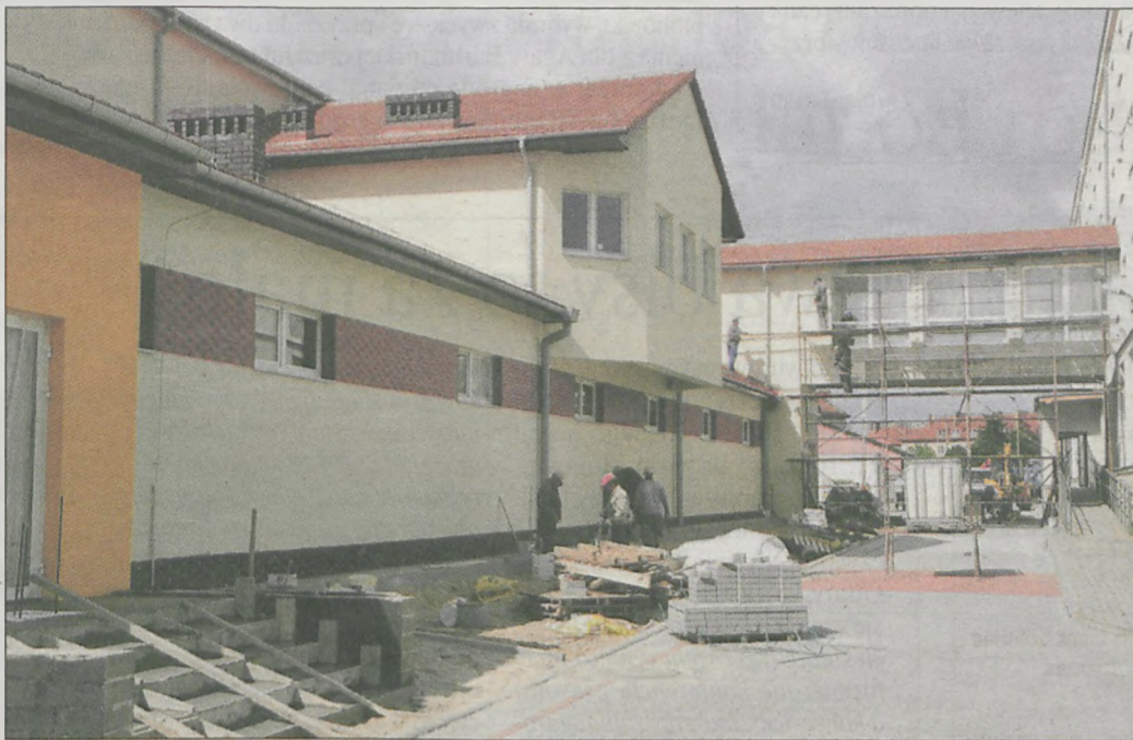
Ekipa budowlana kończy pracę przy sali sportowej ZSP nr 2
