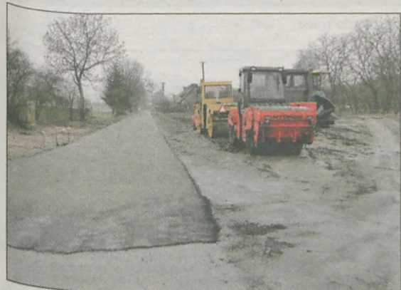
Drogowcom pozostało położenie na drodze w Gąsiorowie ostatniej - ścieralnej warstwy asfaltu i prace porządkowe
