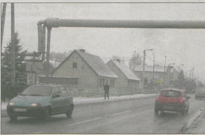
Rury nieczynnego ciepłociągu niebawem powinny zniknąć z drogi krajowej nr 11
