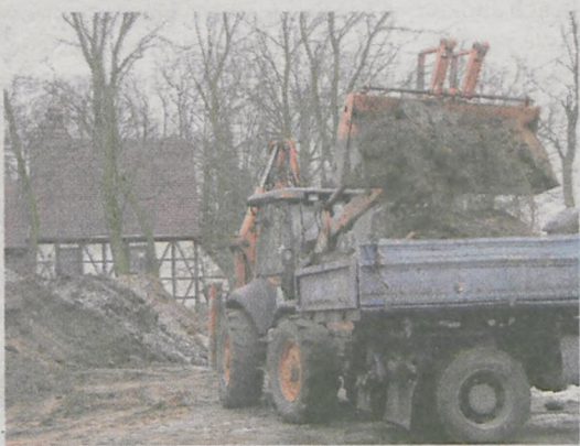
Od kilku dni trwają prace nad wyrównywaniem terenu
