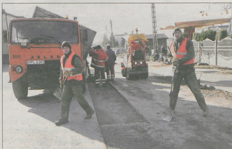
Ostrowska firma zasypała rów na ul. Podlesie w Witaszycach i wpięła rury do kanalizacji odwodnieniowej ul. Cmentarnej
