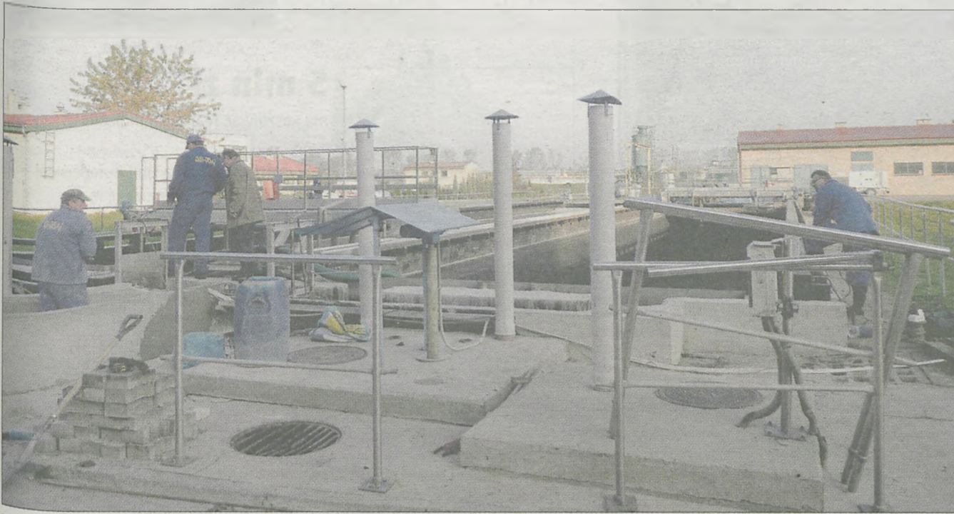
Eko-Dbaj zajmuje się eksploatacją oczyszczalni ścieków w Cielczy oraz utrzymaniem sieci kanalizacyjnej
