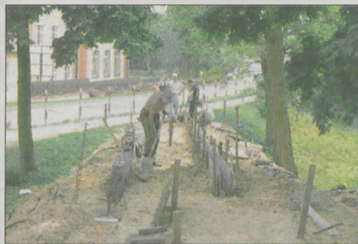
PODJAZD DLA OSÓB NIEPEŁNOSPRAWNYCH wybudowano przy ul. Jarocińskiej 7 w Jaraczewie
