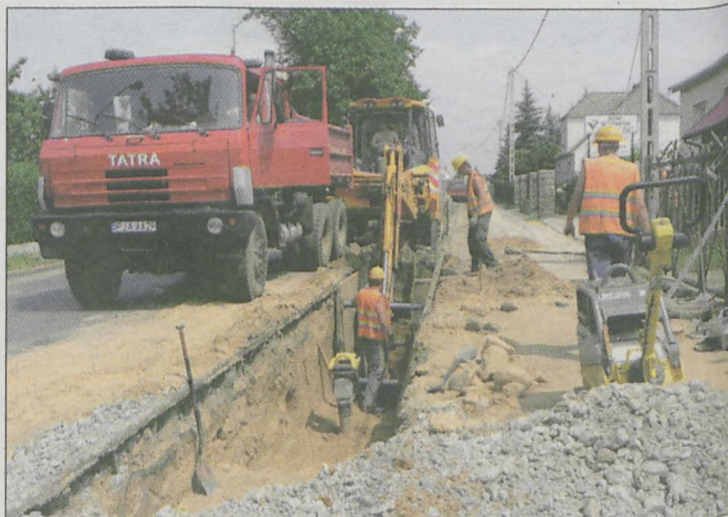
BUDOWA KANALIZACJI DESZCZOWEJ na ul. Żerkowskiej zakończy się na przełomie sierpnia i września
