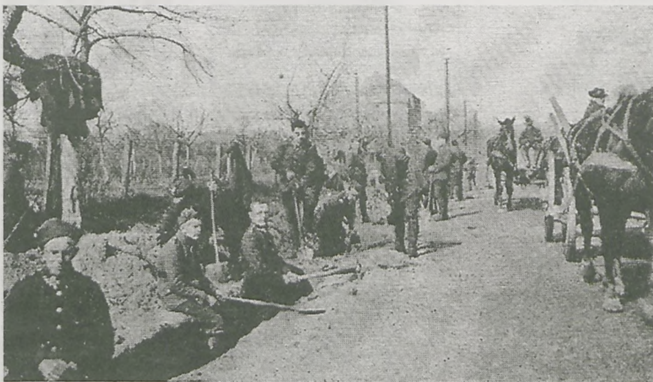
Odkopywanie zamrzniętych rur wodociągowych w 1929 roku
