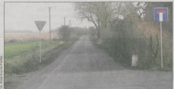
ROBOTY DROGOWE WYKONANE zostały na odcinku 200 metrów
