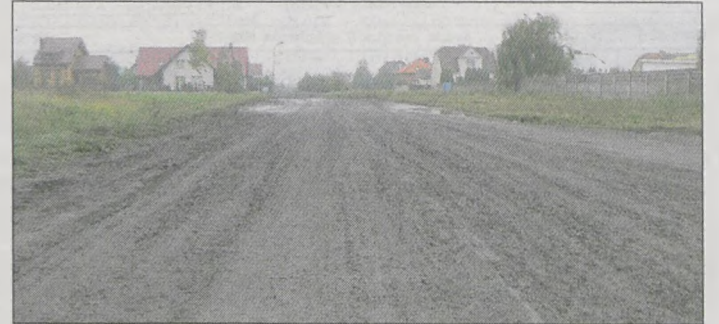
UL. WIELKOPOLSKA jest drogą dojazdową do Powstańców Wlkp. Ten odcinek w tym roku w ogóle nie był utwardzany tłuczniem
