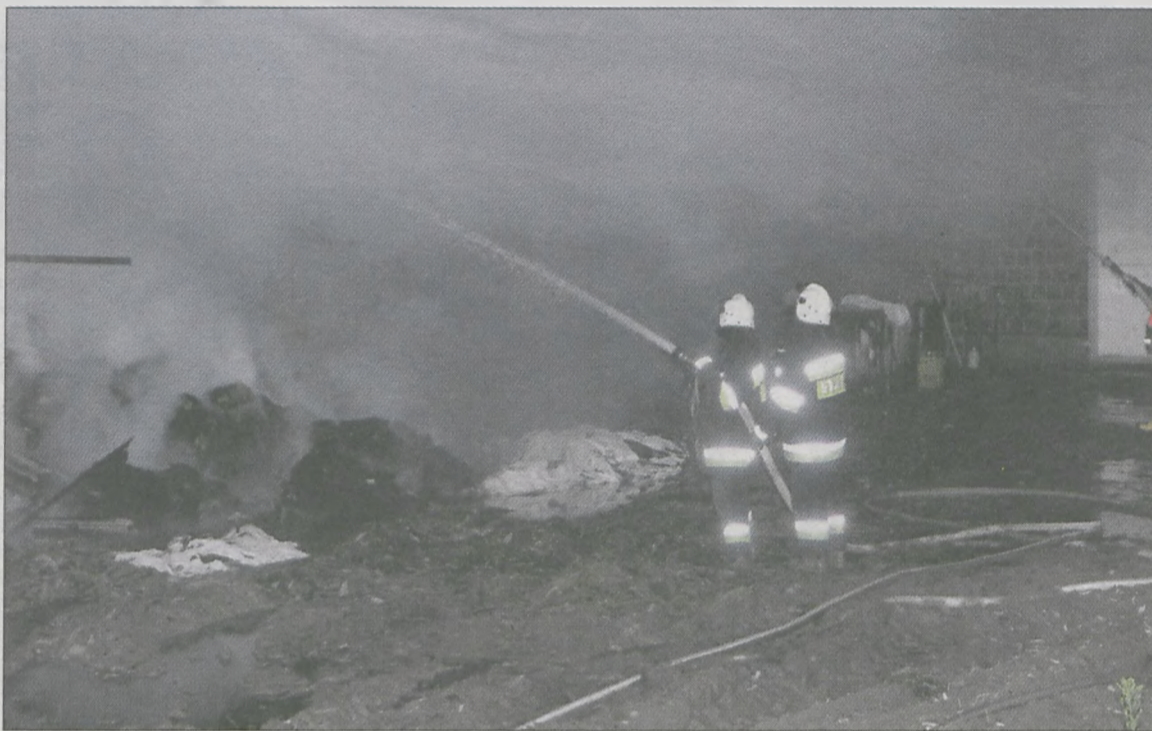
OGIEŃ STRAWIŁ dach stodoły
