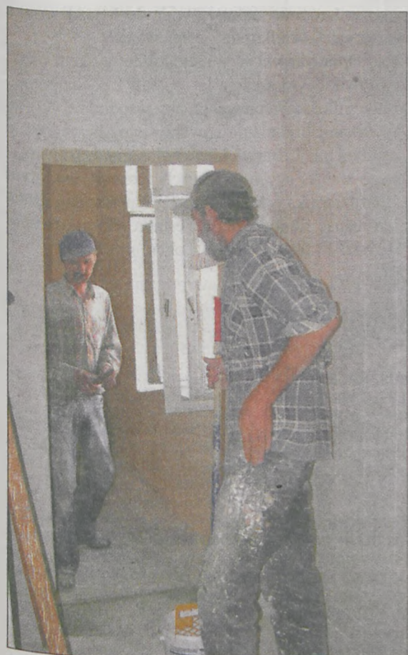
W GÓRZE trwa adaptacja pomieszczeń na lokale socjalne
