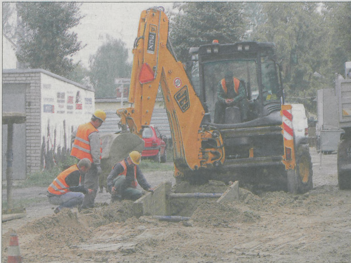
OBECNIE TRWAJĄ PRACE związane z budową kanalizacji na osiedlu 1000-lecia. Niebawem wymieniany będzie tam wodociąg. I, jak zapowiada prezes PWiK-u, każda z posesji ma być wyposażona w studnię wodomierzową
