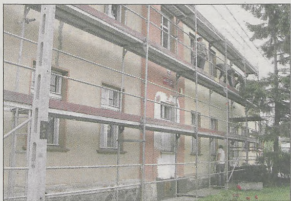
NA POCZĄTKU LIPCA pomalowano elewację budynku przedszkola w Jaraczewie
