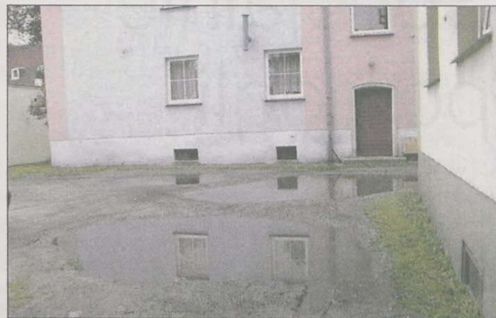
MIESZKAŃCY twierdzą, że po ulewach podwórzu jest pełne wody
