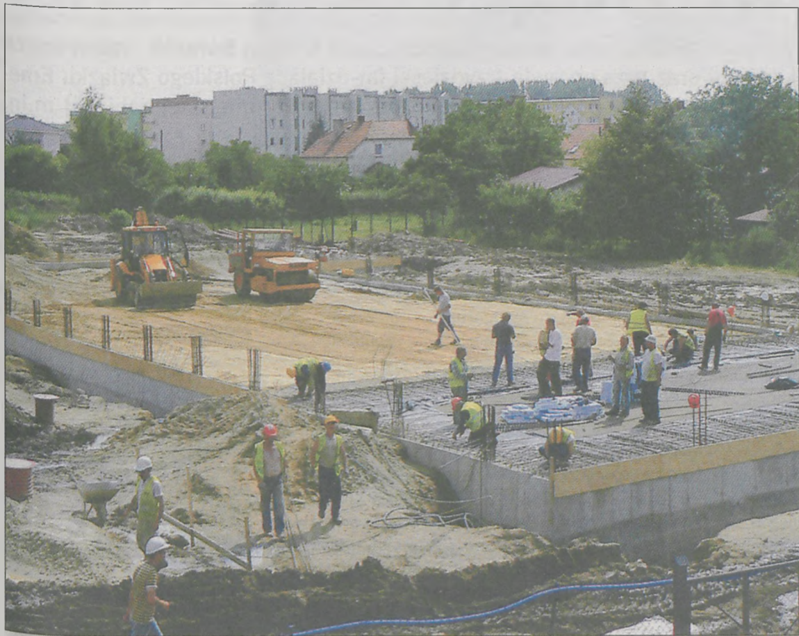
ROBOTY NA DZIAŁCE, na której stanie market, trwają od połowy czerwca
